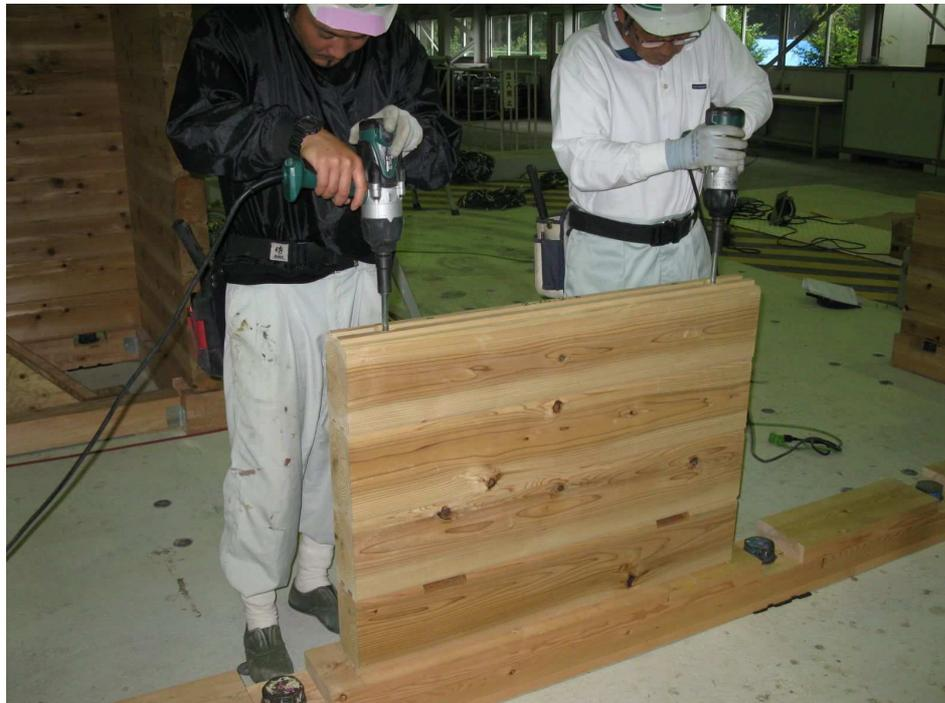
写真-3.1.4 鋼製ダボ施工状況
