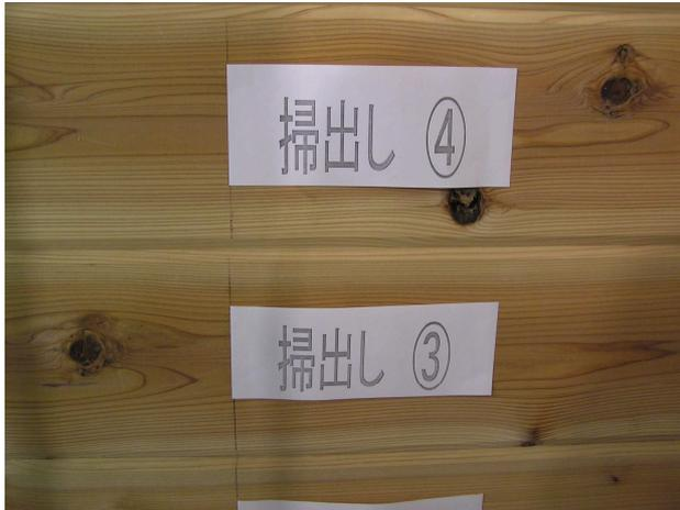
写真-6.1.1 ログ材間の水平ずれ
