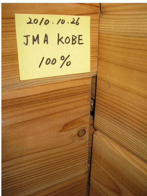
写真-6.2.1 ノッチ部水平ずれ
