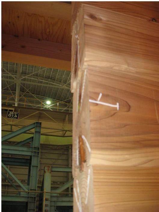
写真-6.2.6 ログ材間の水平ずれ
