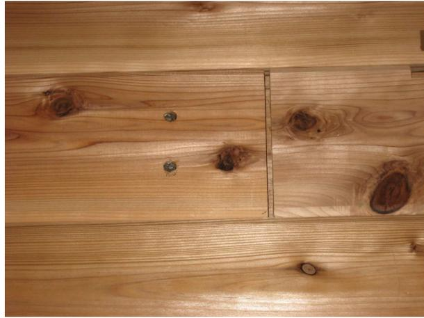
写真-6.3.9 水平継ぎ手部の開き
